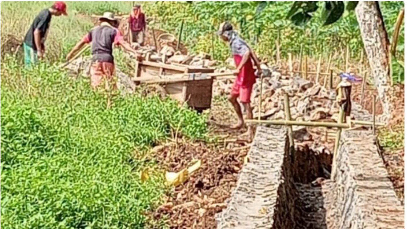
Warga Desa Banyubiru Kecamatan Labuan Bangun Drainase
